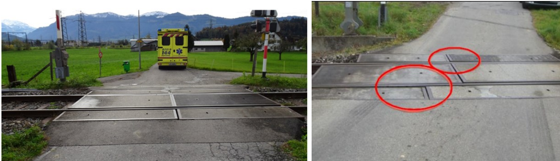
Abbildung 11-2: Spalten im Bereich von BUe, minimaler Winkel
